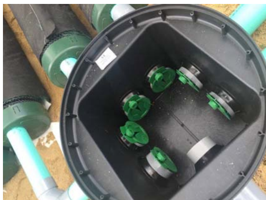
Figure 7 : Représentation de la boîte de distribution D-Box 20
