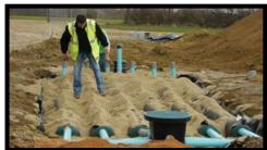
Recouvrer de sable filtrant sur une hauteur de 10 cm sur les conduites Enviro))Septic.
