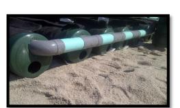
Insérer la colonne de ventilation dans les trous du haut de l'adaptateur 2 trous avec une légère pente de 1% vers les conduites Enviro))Septic pour éviter l'accumulation de condensation.
