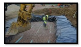
Positionner les rangées de drains (voir plan) ainsi que le regard de collecte. Ce dernier doit être raccordé sur le tuyau d'évacuation et être comblé de 10 cm de gravier stable à l'eau de diamètre 10/40 mm.
