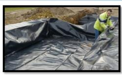
Déployer et positionner votre géomembrane 1.2 mm sur l'ensemble de la surface.
