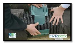
Installer les manchons sur les conduites en plaçant les rainures dans les cavités des conduites.
