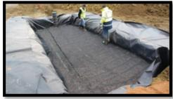
Recouvrer le gravier avec la grille de filtration (géogrille).
