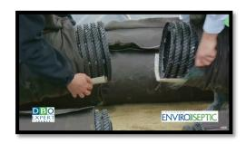
Dégager les membranes géotextile des extrémités des conduites à relier.
