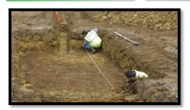
Préparer le sol récepteur en le mettant à niveau et retirer tout objet pointu du fond de la fouille.
