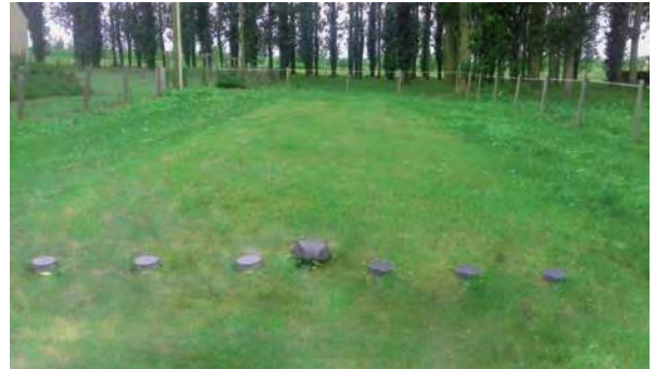
Remise en forme du terrain et engazonnement.
