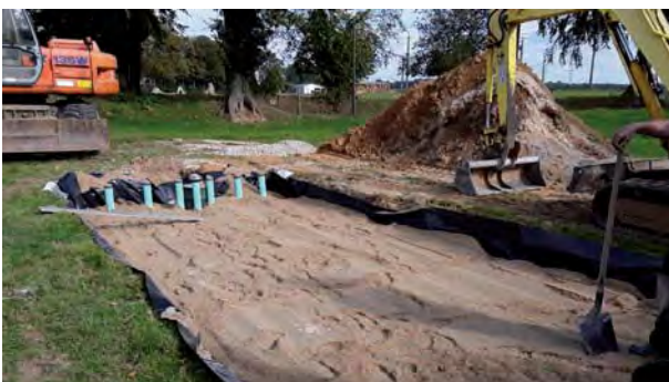
Remblai des conduites avec 10 cm de sable filtrant et 50 cm maximum de terre végétale (perméable à l'air).
