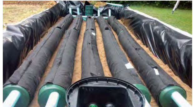
Insallation des conduites selon le plan fourni.
