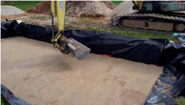
Pose du sable filtrant sur 30 cm réglé de niveau
