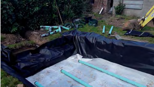
Pose des géotextiles de protection de la membrane et de la colerette d'étanchéité.
