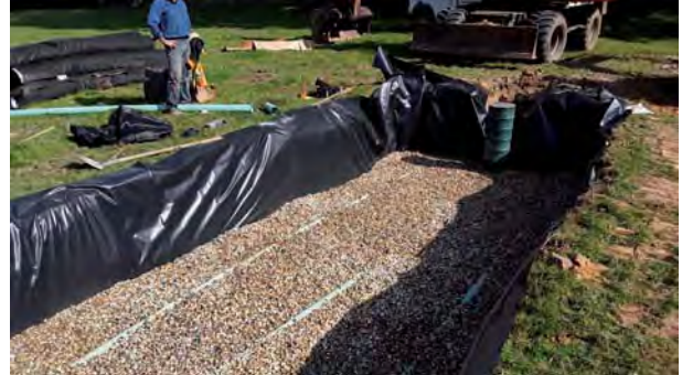
Pose du regard de collecte, épandage et gravier.
