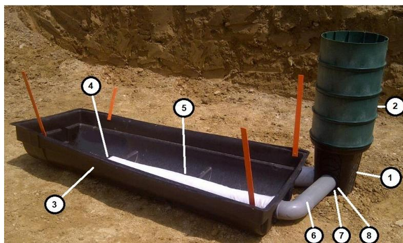
Figure 9 – Dispositif d'échantillonnage
